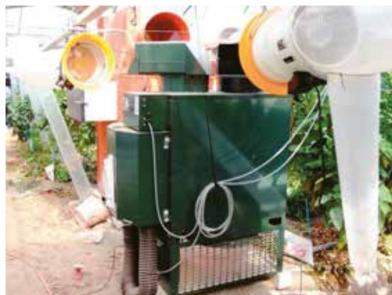
写真4 ハウス内の環境制御装置(写真はCO 2 発生機)
