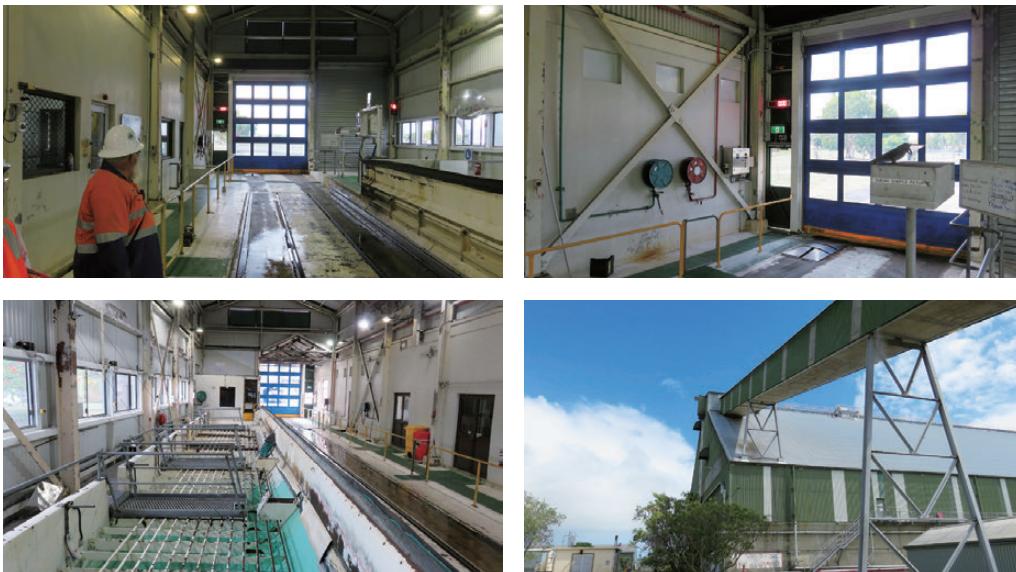
写真5 バンダバーグ港のトラック計量場（ドライバーは一度も降りることなく、荷下しが可能）（左上）計量メーター（右上）、粗糖投入口（左下）、倉庫への栈橋（右下）
