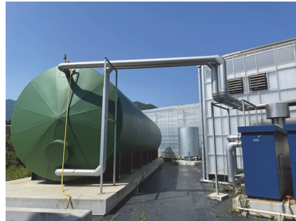
写真2 発電施設（左）、蓄熱タンクとバックアップボイラーの外観（右）
