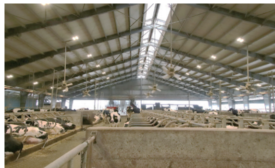
写真1 2021年に建設した牛舎 搾乳ロボットや自動給餌ロボットを導入している。
