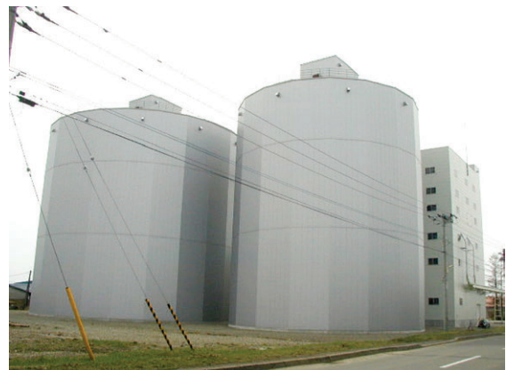
写真3 サイロ（左：大粒子用1万トン、右：小粒子用5千トン）
