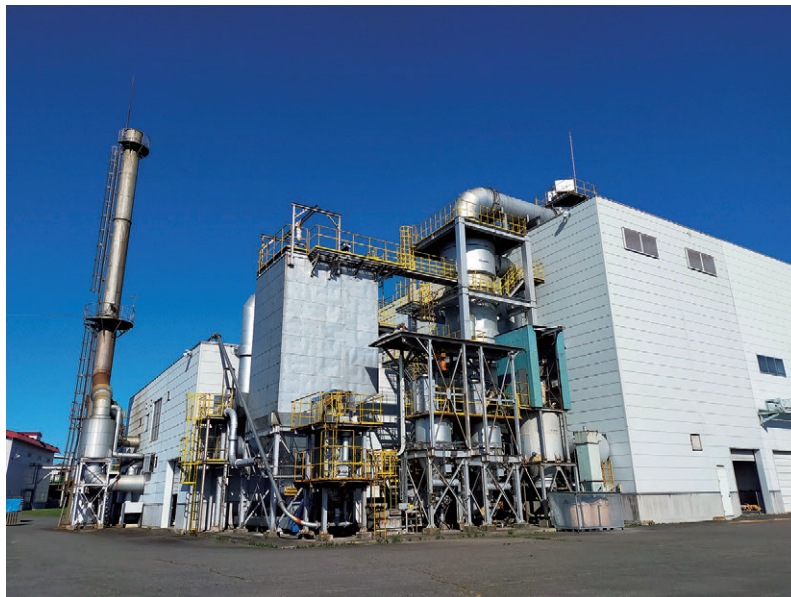
写真9 士幌でん粉工場外観
