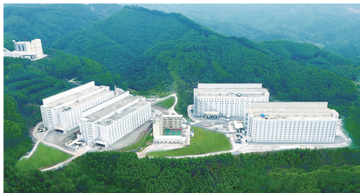
写真2 揚翔の養豚ビル（広西チワン族自治区、提供：揚翔グループ） （左側2棟：初代の7階建て養豚ビル（繁殖雌豚3万頭規模）。 ASFの侵入を防いだことで「ビル養豚」を一躍有名にした。 右側2棟：2代目の9階建て養豚ビル（繁殖雌豚3万頭規模）。 中央1棟：従業員の宿舎兼福利厚生施設。）
