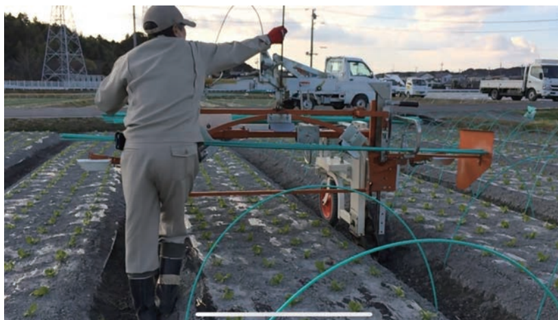
写真2 ポール打ち機による作業風景
