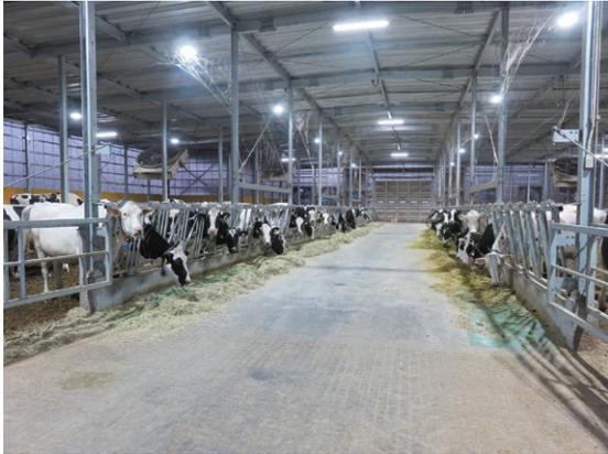
写真4 ダブル折板方式を採用した快適な牛舎(搾乳牛舎)
