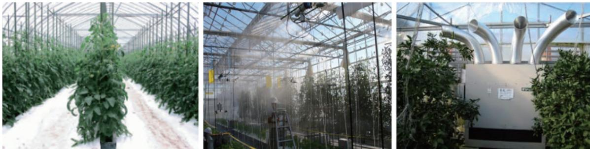
写真4 地温抑制マルチ（左）、細霧冷房（中）、ヒートポンプ（右）
