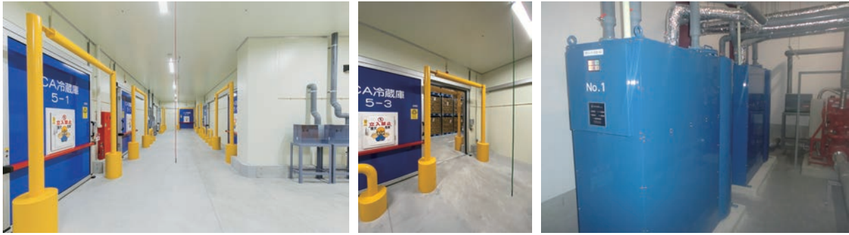
写真2 CA冷蔵庫（左から外観、入口から見た庫内の様子、二酸化炭素濃度調整機器）
