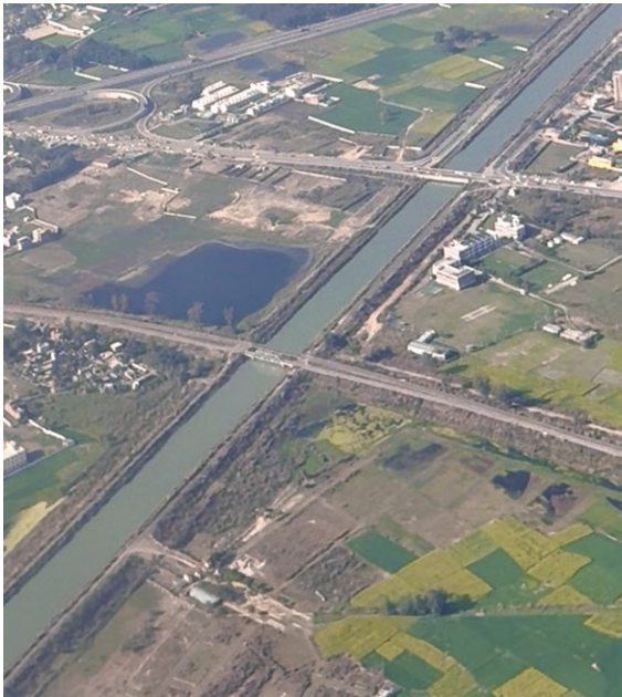
写真4 整備された河川と灌漑施設（ため池）
